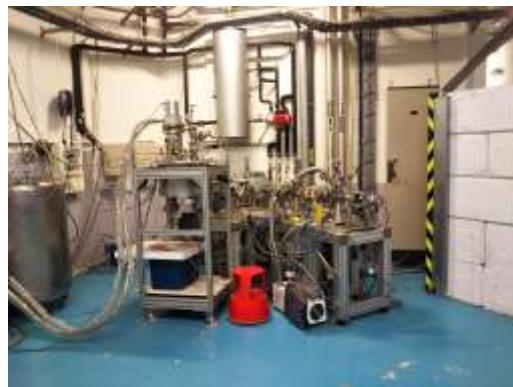
電子線照射設備
